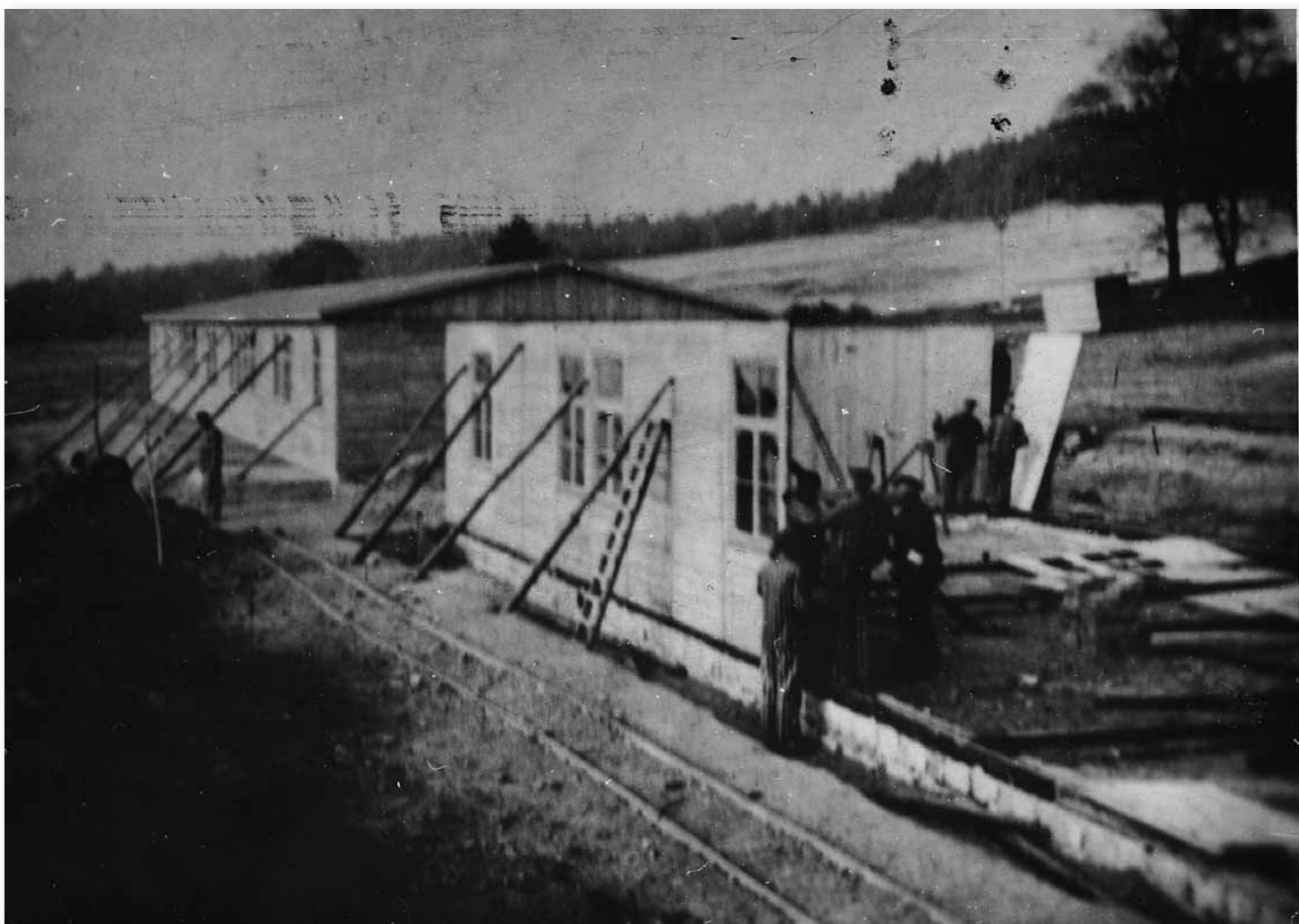
Więżniowie przy budowie baraku na terenie KL Groß-Rosen, 1941 r. (AMGR)
